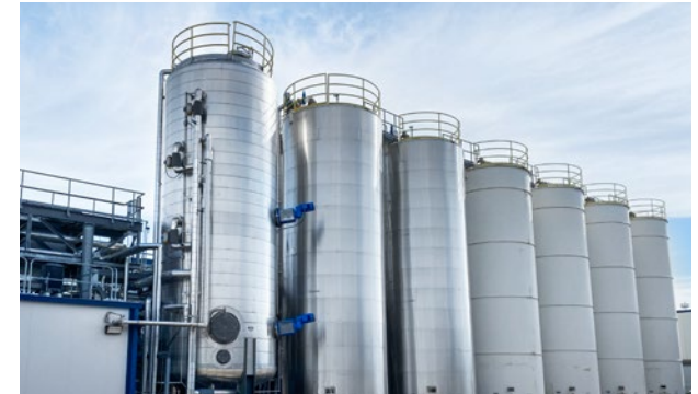
Neue Stoßdämpferölanlage in Harvey
